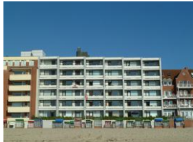
die beliebte Apartementanlage "Haus Irma" - Sie haben direkten Strandzugang durch den Keller
